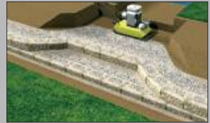
Hinterfüllen und Verdichten
