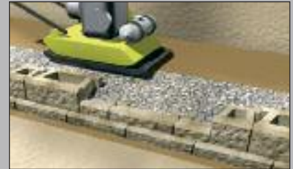
Verlegung der nächsten Blockreihe und Geogitterlagen
