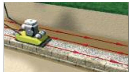
Hinterfüllen und Verdichten
