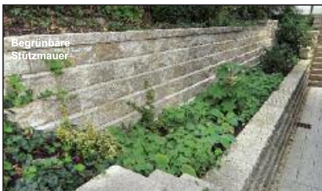
Eine große Stützmauer
