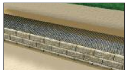
Verlegung der nächsten Blockreihe und Geogitterlagen
