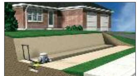
Abritteln und verdichten
