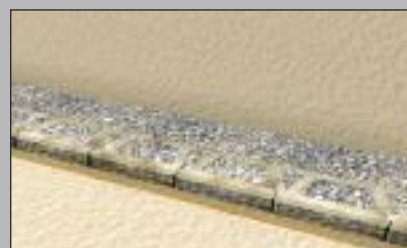
Dränagematerial und Füllmaterial verfüllen
