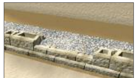
Dränagematerial verfüllen
