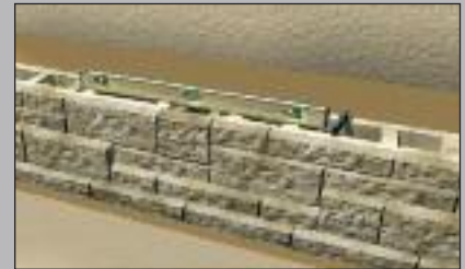
Fertige Reihe, Höhe und Geradlinigkeit
