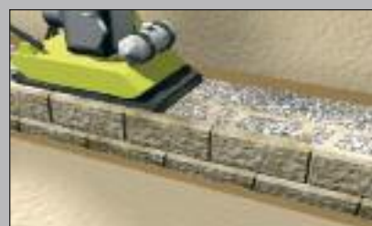
Hinterfüllen und Verdichten
