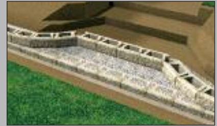
Ausrichten der ersten Treppenstufe
