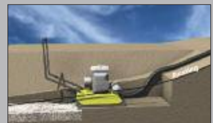
Den nächsten Aufstieg ausschachten und verdichten
