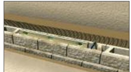
Verlegung der nächsten Reihe
