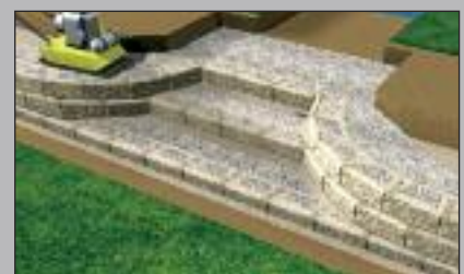
Hinterfüllen und Verdichten
