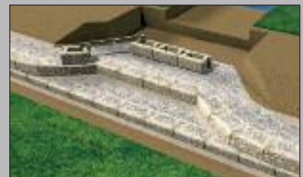
Einbau der nächsten Treppenstufe
